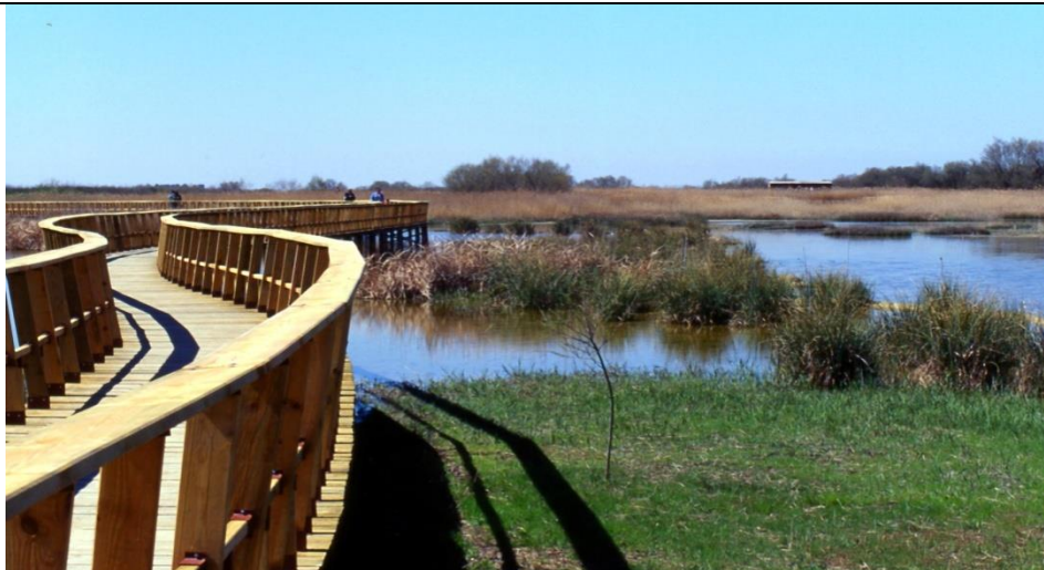
IMAGEN Nº1: Vista de la pasarela sobre la laguna, Tablas de Daimiel, Ciudad Real.
